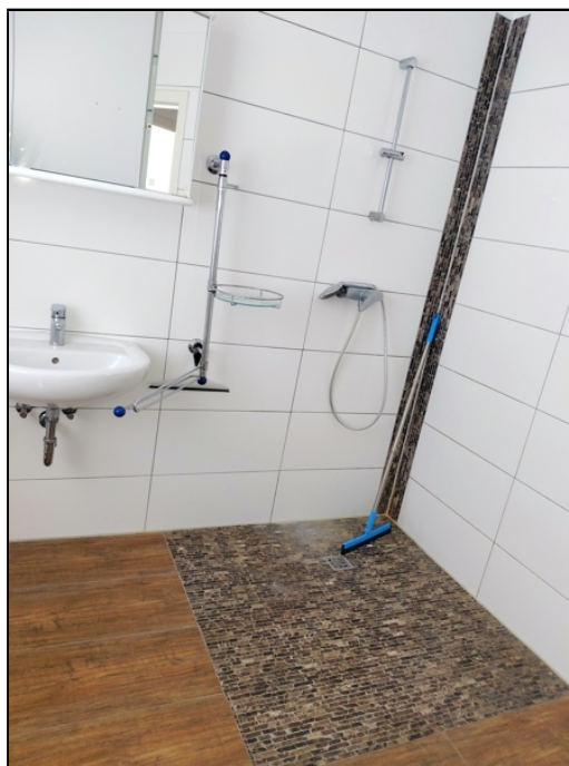
Duschbad mit Fenster
