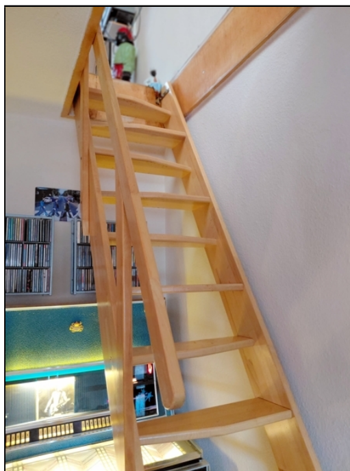
Treppe zum Spitzboden
